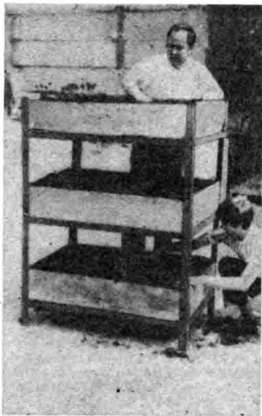
Рис.6. Трехъярусный контейнер для выращивания шампиньонов
